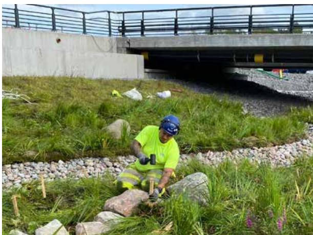
Strandmattan fästs med förankringsfäste i trä och placeras på rätt nivå i förhållande till medelvattennivån.
