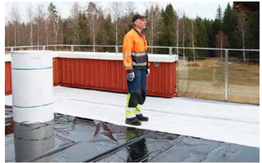
Utrulling av ND 220 over rotbeskyttelse
