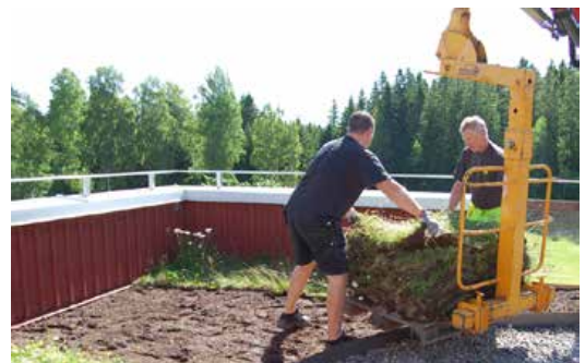
Montering av tørrengmatte.
