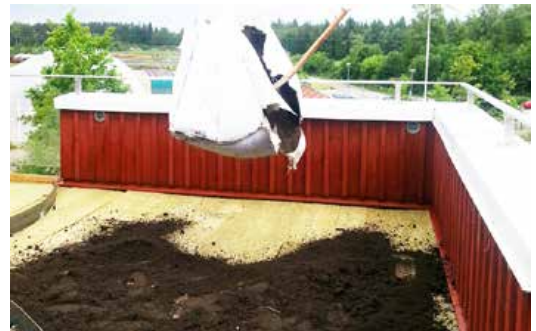
Utlekking av VegTech Takjord.
