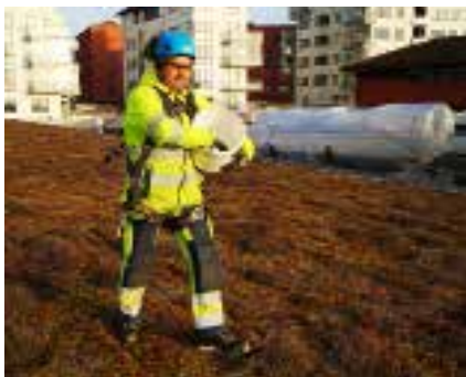
Gjødsling av sedumtak.
