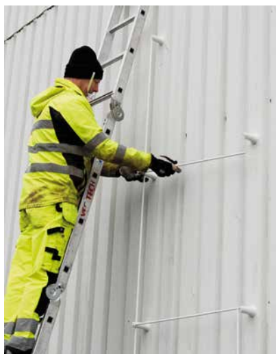
Tobrafix på byggnad
