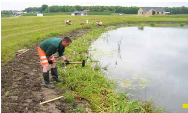
Bassin til regnvandsopsamling i Randers.
