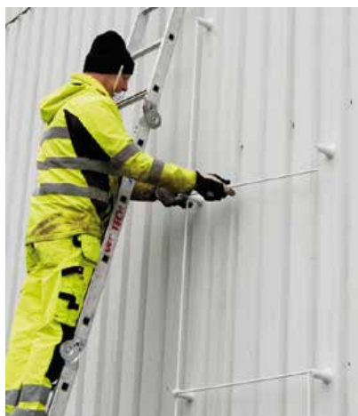
Tobrafix på bygning
