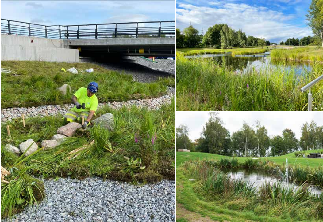
Montage av strandmattor i barkabystaden, Fittja dagvattenpark, Parkdamm Strandängen, Jönköping
